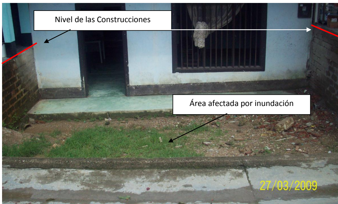
Zona 3. Vivienda en riesgo alto por inundación debido al grado de vulnerabilidad física en el que se encuentra. En el plano urbano no se define la amenaza por inundación hasta este sector. (Vivienda ubicada en la carrera 6)
